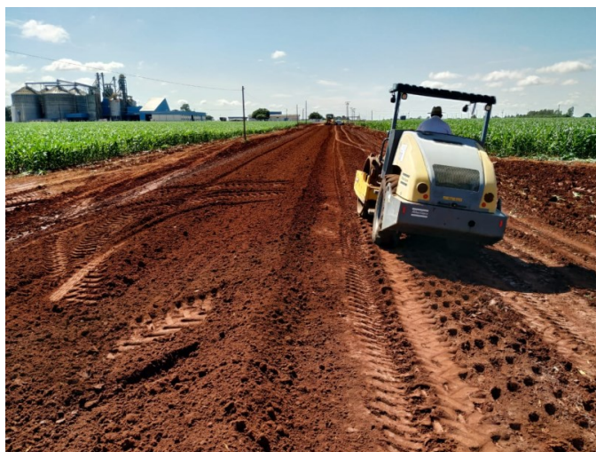
Figura 5: Compactação com rolo da estrada
