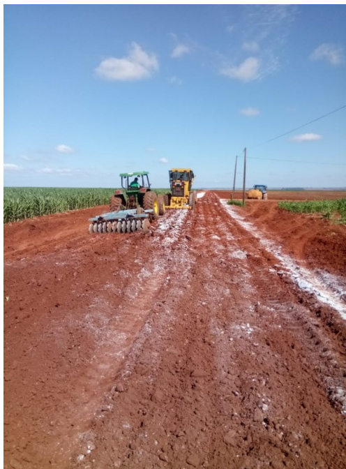
Figura 3: Incorporação do produto na camada de 20 cm
