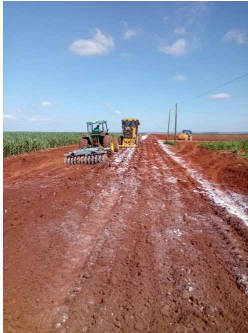
Figura 3: Incorporação do produto na camada de 20 cm
