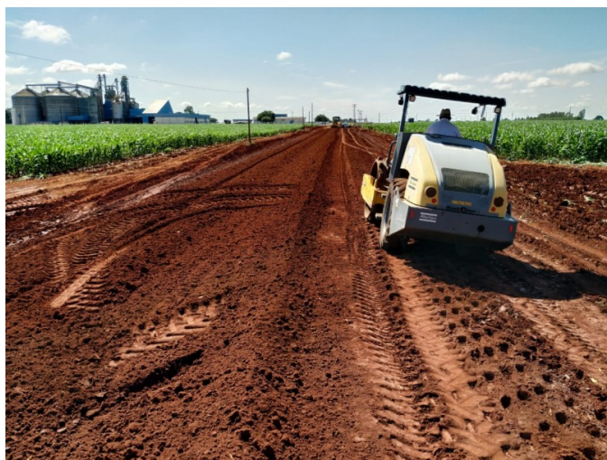
Figura 5: Compactação com rolo da estrada
