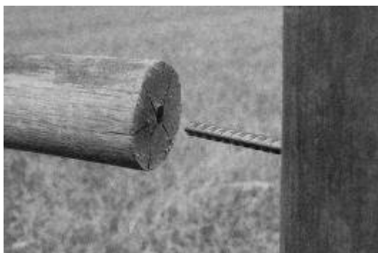
Figura 20: Trava com pino cavilha
